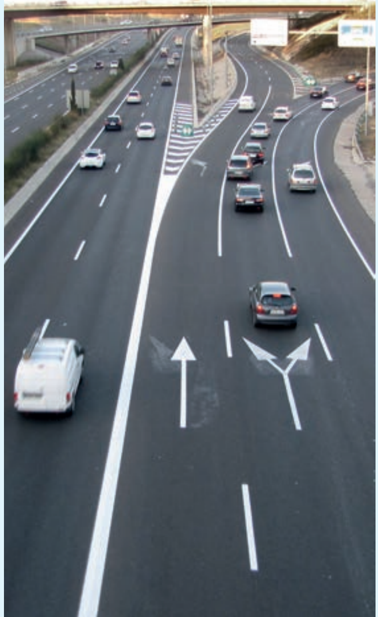
Modelo de salida de "altas prestaciones", mediante doble carril, en la CV-30 de Valencia.
