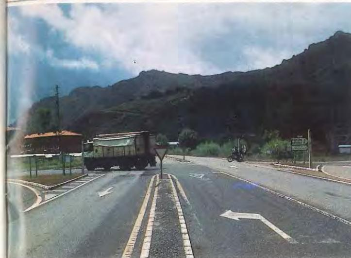
El descenso hasta León desde Pajares cambia la N-630: arcenes amplios, vallas protectoras, firme en buen estado, pintura correcta y señalización en buen estado.
