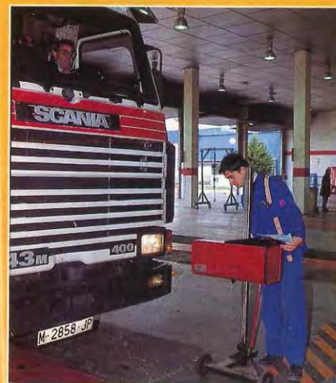
Comprobación del correcto funcionamiento de los sistemas de alumbrado y de señalización.
