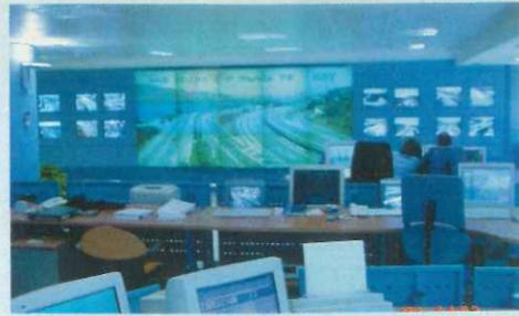
Este centro –operativo 24 horas al día, 365 días al año– se basa en un anillo de fibra óptica y obtiene información de 59 cámaras, 61 estaciones meteorológicas y 180 puntos de medición, así como un sistema de señalización variable. Con estos datos, el Centro –que ha necesitado una inversión de 24,42 millones de €– mo-
